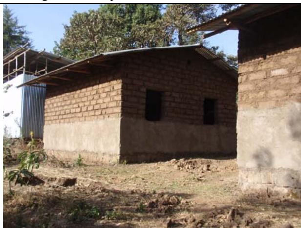
Demonstrationsbyggnader – uppförda av adobeblock.
