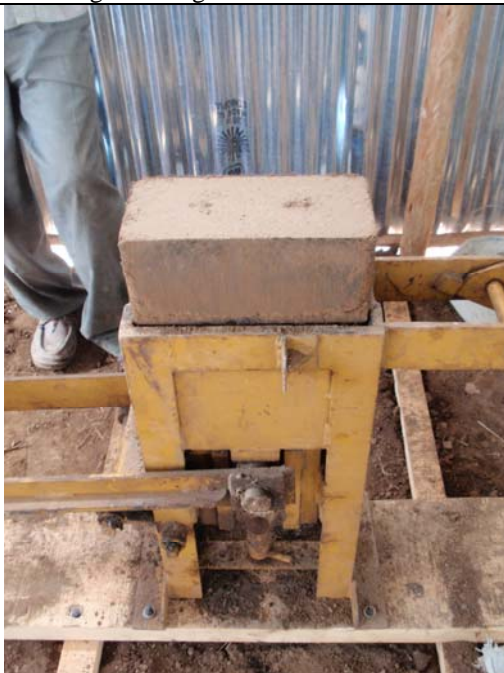
Tillverkning/pressning av cementstabiliserat block.
