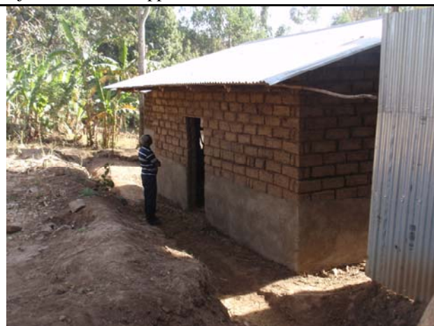
Demonstrationsbyggnad – uppförd av adobeblock.
