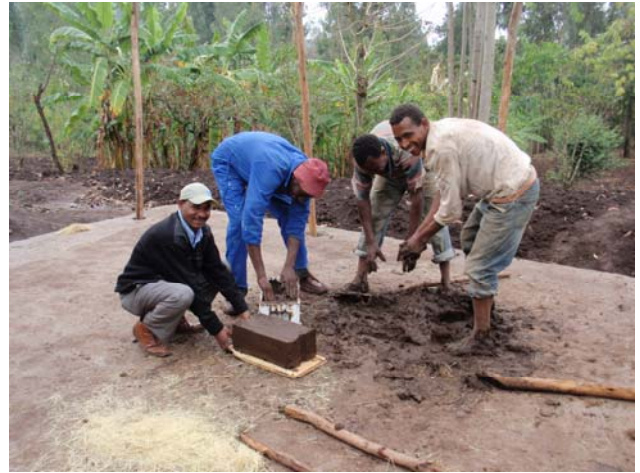
Tillverkning av adobe-block.
